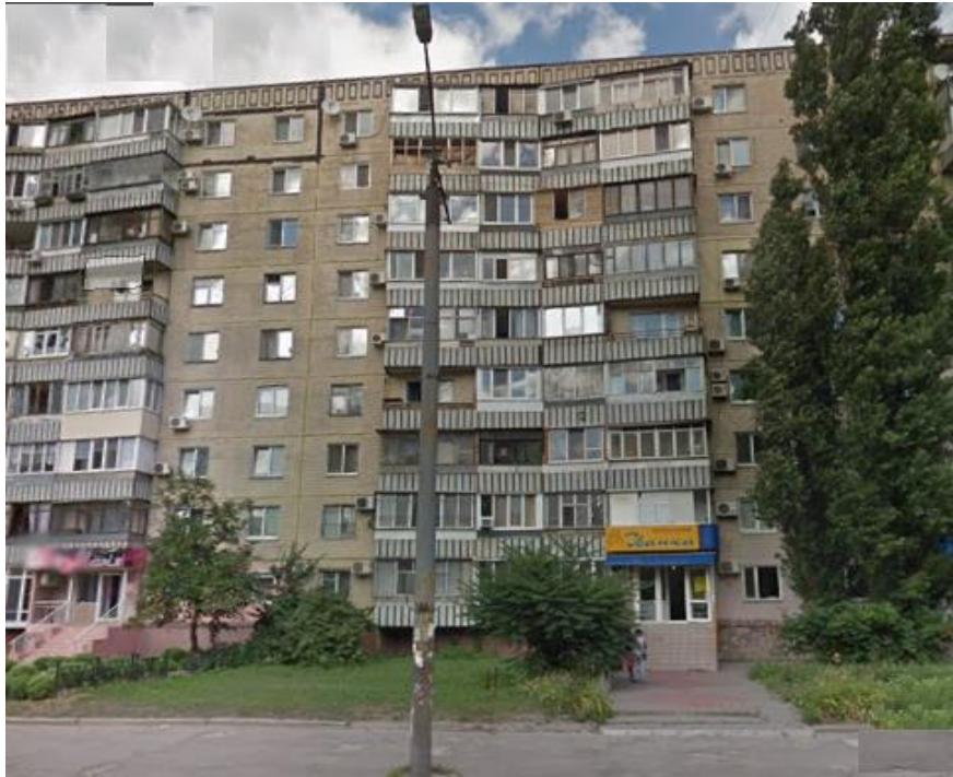
Рис. 1. 9-ти поверховий панельний житловий будинок де виконувалися виміри на проспекті Героїв 21
