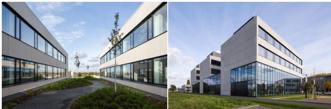
Фиг. 5. Център за фотоволтаични елементи и възобновяема енергия - озеленен покрив и поглед от югозапад. Между-блоковите покривни градини оптимизират микроклимата на сградата (постига се естествена осветеност и напречна вентилация на офисите и лабораториите) и предлагат на служителите среда за краткотраен отдих
