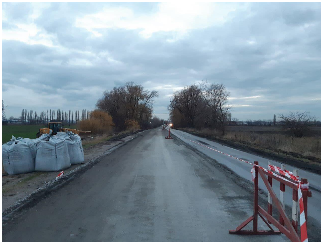
Рисунок 2. Загальний вигляд влаштованого шару із МДХР.МВ.Кз.М40
