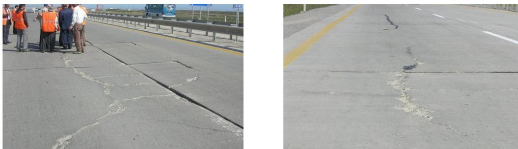
*Рис 1. Трещины на автомобильной дороге Баку-Губа-гр. России с цементобетонным покрытием.*
